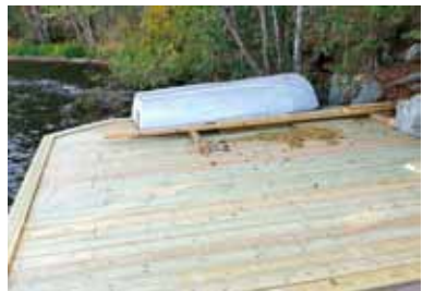
Norra bryggan under renovering. Foto: Göran Westlund
